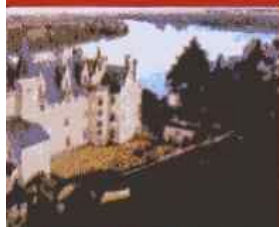
CHÂTEAU DE MONTSOREAU
