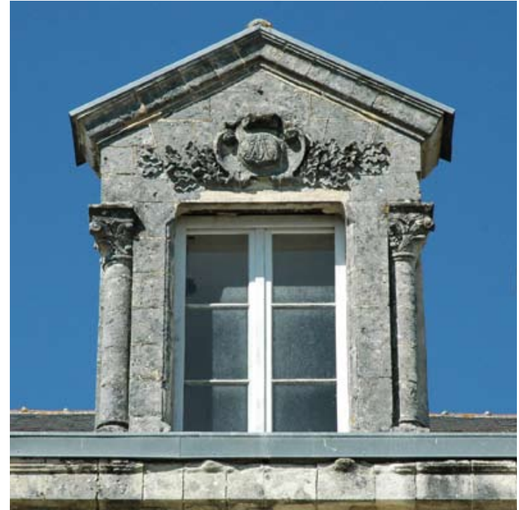
Image 84: Lucarne façade avant, colonnettes couronnées par un chapiteau, Fronton triangulaire surbaissé sans-retour
