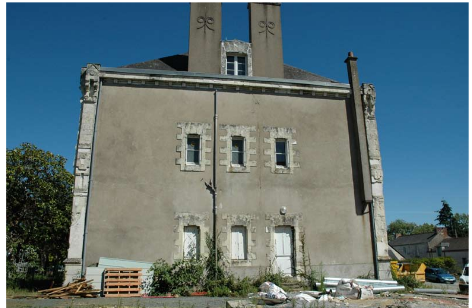
Image 67: pignon façade Ouest, moins d'ornements, régularité, joints lisses, baies en harpage
