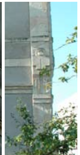
Images 75 et 76: pilastres angulaires
