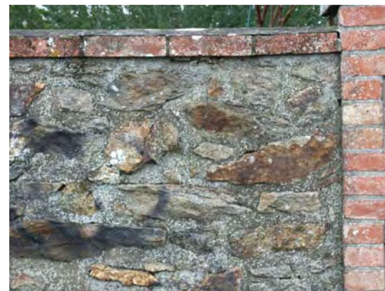
Mur de clôture et pilier en moellon, soulignés par la brique en référence aux matériaux de façade de la villa associée.
